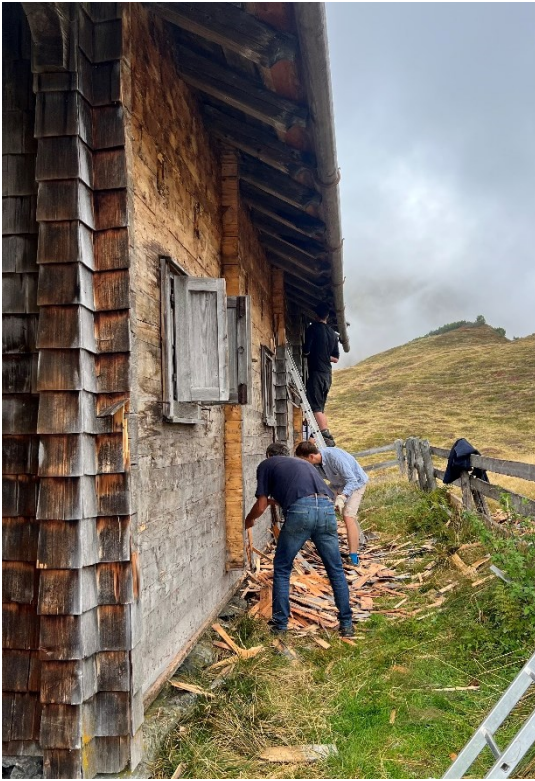
Der Abriss war in 3 Stunden geschafft.
